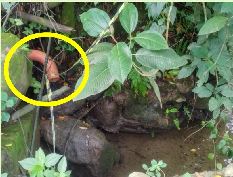
Tubo condutor de efluente de esgoto tratado da ETE CDHU
