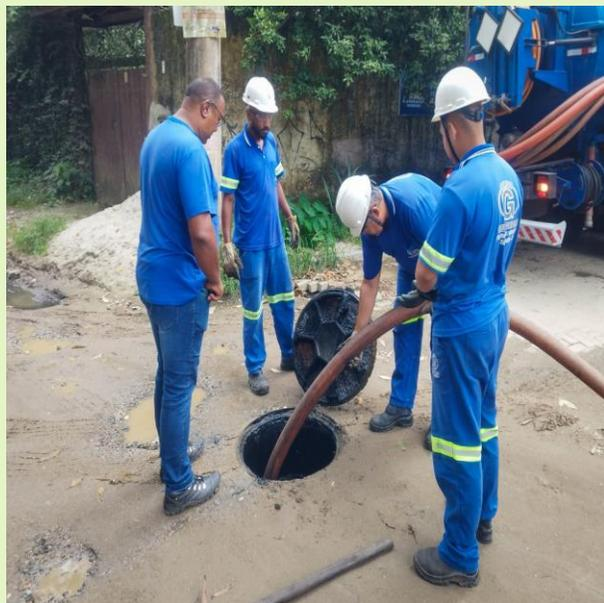
PV ESQUINA RUA NOVA IGUAÇU COM RUA BRAZ FIDÉLIS - ESGOTAMENTO E BLOQUEIO DO TRONCO COLETOR
