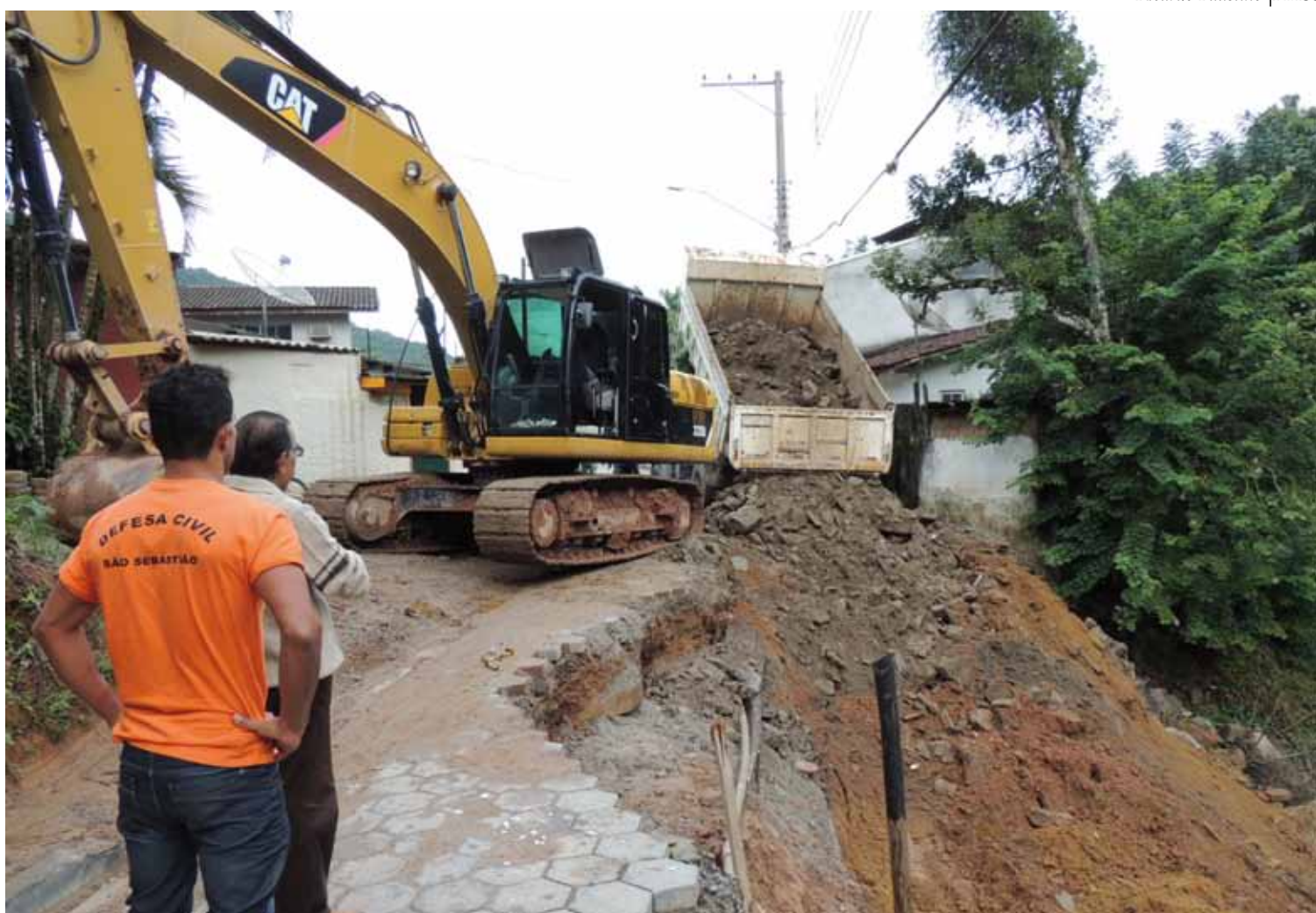
Escavadeira PC de aproximadamente 20 toneladas opera no local
