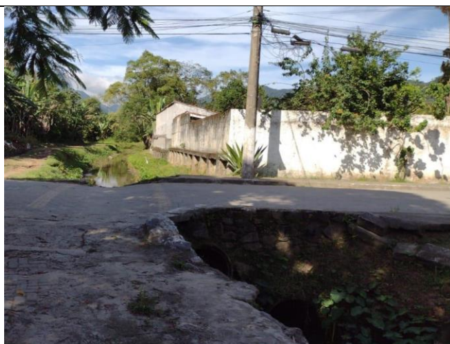
Foto 13 Travessia de canal na Rua Galdino Rodrigues com Rua Francisco Scarpa.
