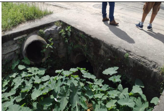
Foto 31 Travessia de curso d'água na Estrada do Cascalho, altura do nº 1429.
