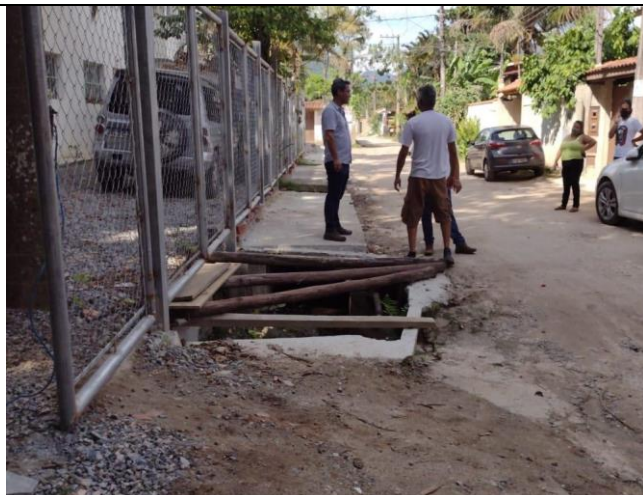
Foto 07 Vista da Rua Itaberaba altura do nº 37/625.
