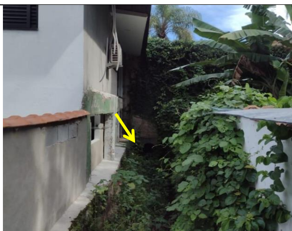
Foto 05 Tubulação de Ø0,80m embocando canal aberto paralelo à Rua Antonio L. dos Santos.
