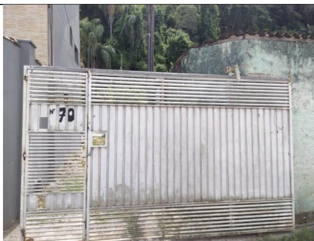
Foto 03 Rua Antonio Ledo dos Santos, nº 70. Local de extravasamento do canal aberto paralelo à via.
