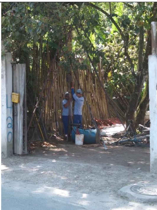
Foto 05 – Perfuração da SP-02.
