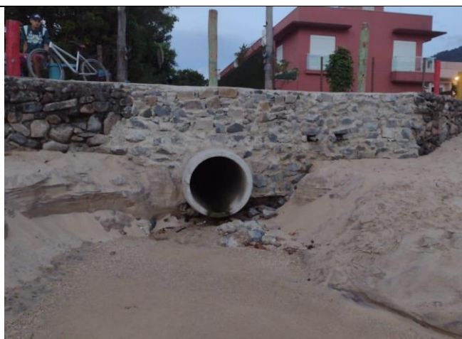
Foto 35 Desemboque de microdrenagem da Rua Itabira Manoel na Praia de Boiçucanga.
