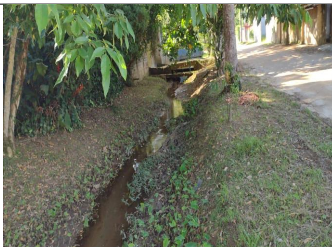
Foto 17 Canal da Rua Havaí Scarpa.
