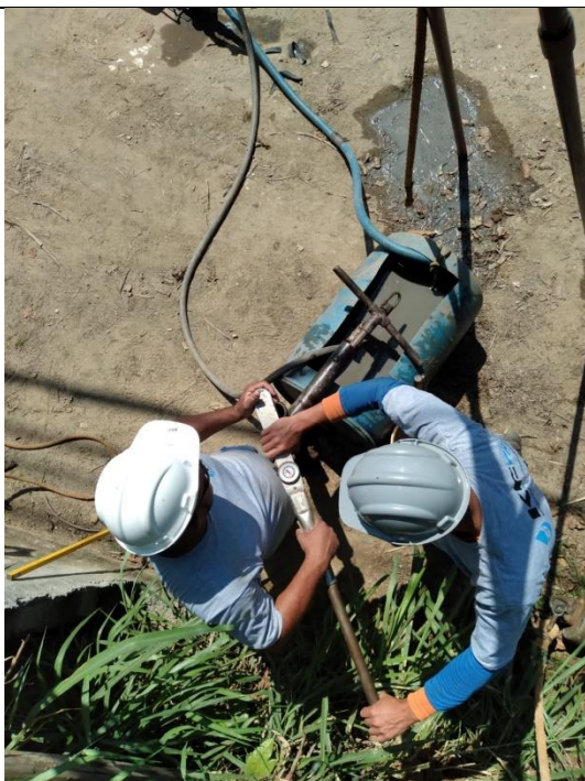
Foto 03 – Perfuração da SP-01.
