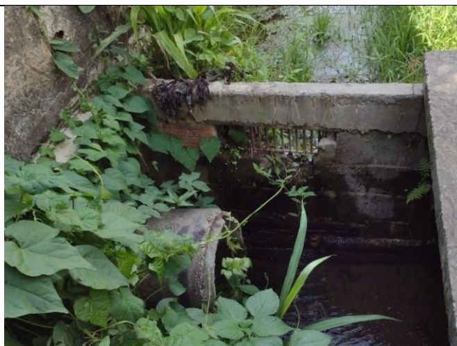
Foto 11 Travessia de canalização de curso d'água oriundo de nascente cruzando Rua Itaberaba.
