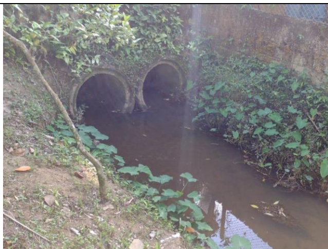
Foto 23 Embocadura de canal aberto junto ao estacionamento da Pousada D'Aldeia.
