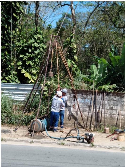
Foto 01 – Perfuração da SP-01.
