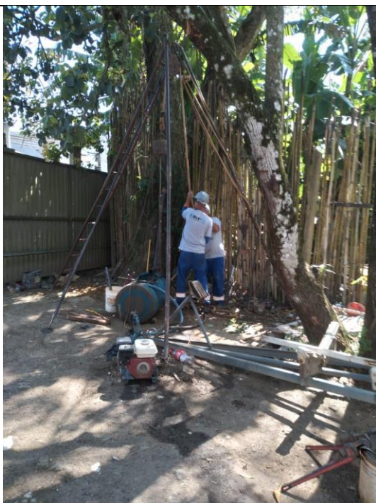
Foto 06 – Perfuração da SP-02.
