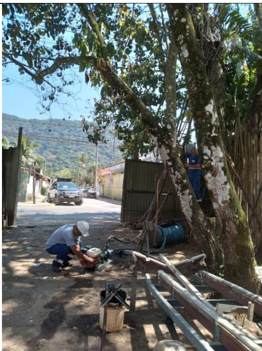
Foto 07 – Perfuração da SP-02.
