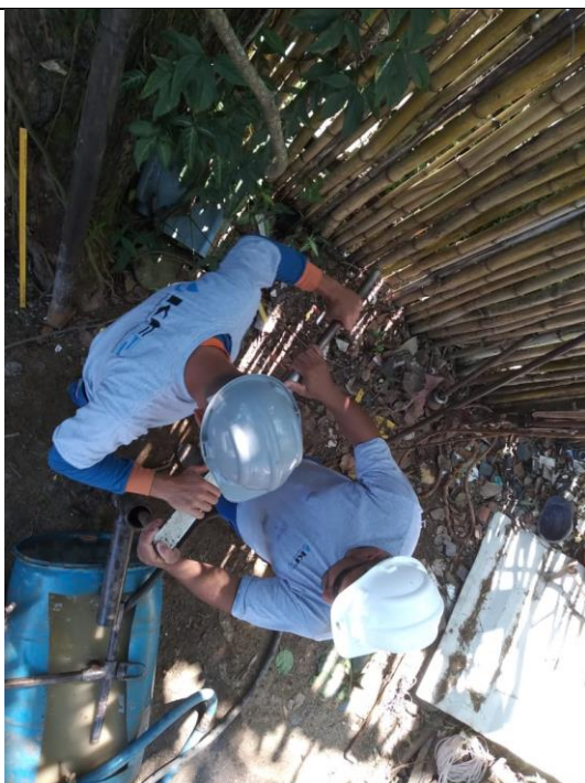
Foto 08 – Perfuração da SP-02.
