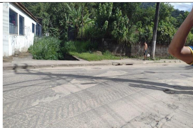
Foto 33 Travessia de curso d'água na Estrada do Cascalho, altura do nº 1429.
