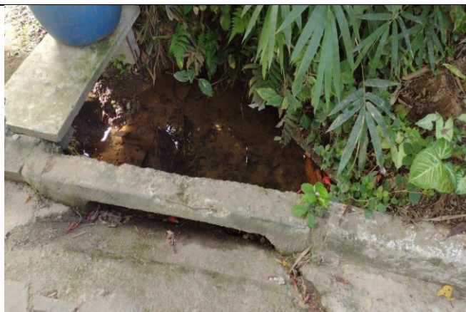
Foto 25 Travessia de curso de nascente na Estrada da Maquininha, alt. nº 500.
