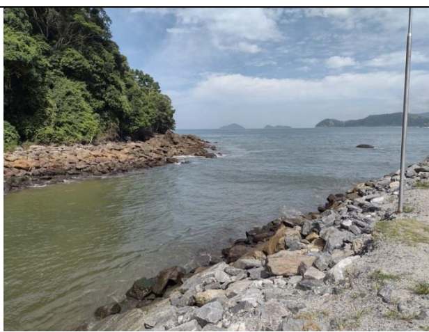
Foto 42 Vista de deságue do Rio Boiçucanga em enrocamento junto ao mar na Praia de Boiçucanga.
