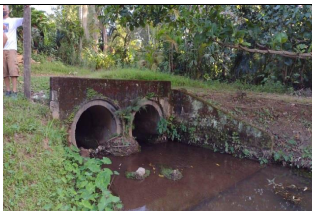
Foto 22 Travessia de canal à jusante do campo de futebol.
