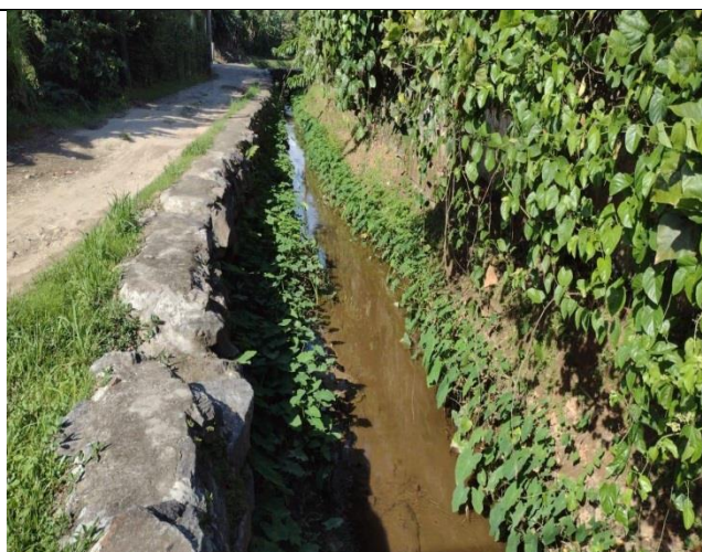
Foto 14 Canal aberto na Rua Galdino Rodrigues.
