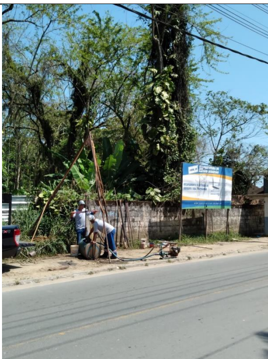
Foto 04 – Perfuração da SP-01.
