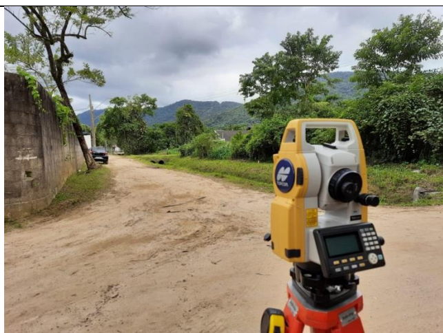
Foto 47 Levantamento topográfico em canal próximo à Rua Butantã.
