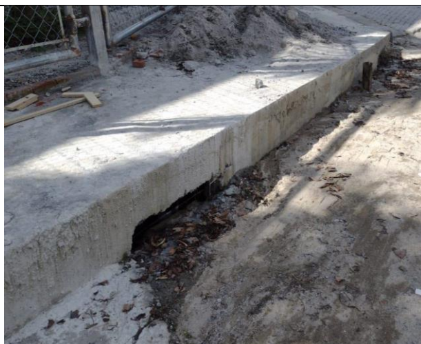
Foto 10 Travessia de canalização de curso d'água oriundo de nascente cruzando Rua Itaberaba.
