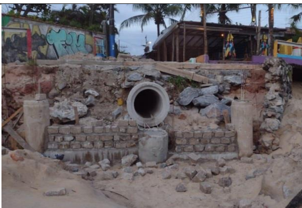
Foto 34 Desemboque de microdrenagem da Rua Maringá na Praia de Boiçucanga.
