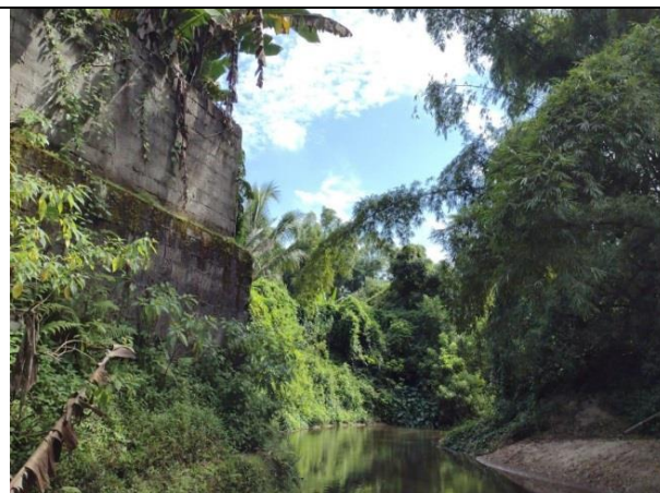
Foto 38 Presença de edificações na Área de Proteção Permanente do Rio Boiçucanga.
