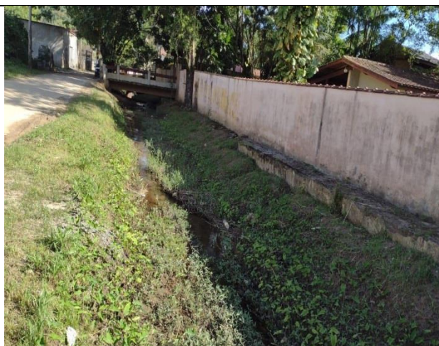
Foto 18 Canal da Rua Havaí Scarpa.
