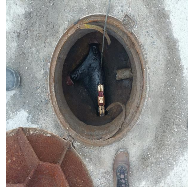
Vídeo inspeção do interior da rede
