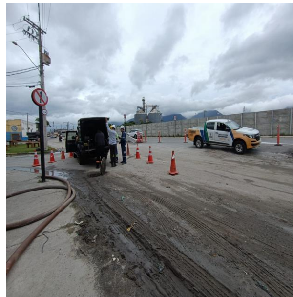
Vídeo inspeção do interior da rede
