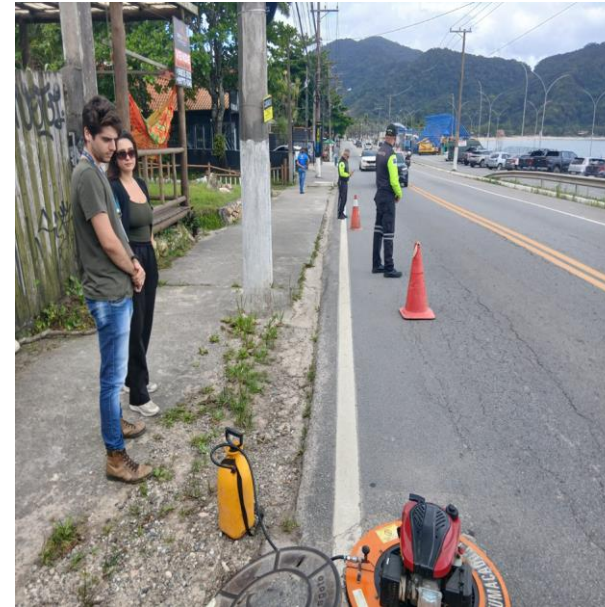
Teste de fumaça na rede de esgoto
