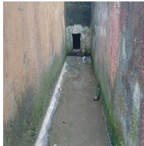
Saída de água proveniente do condomínio alcatrazes
