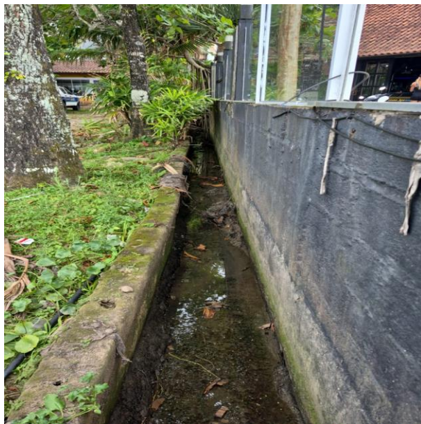
Chegada da vala em drenagem pública
